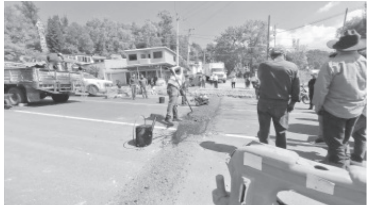
Para dar solución a tres bloqueos simultáneos en la carretera Zitácuaro-Morelia, el Gobierno Municipal de Zitácuaro, a través de la Dirección de Obras Públicas, instaló tres topes provisionales sobre esta vía: uno a la altura de Valle Verde, otro en San Felipe y uno más en Ocurio.
