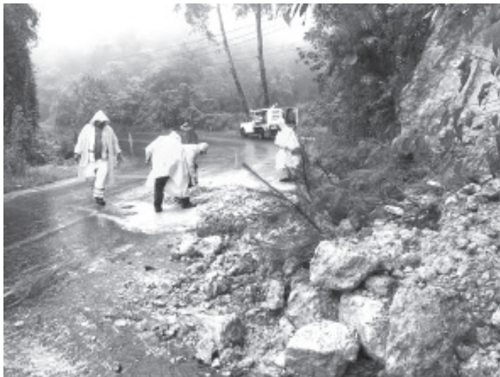
Morelia, Michoacán, 14 de junio de 2026.- La Secretaría de Comunicaciones y Obras Públicas (SCOP) se encuentra lista para la temporada de lluvias con un protocolo de atención inmediata ante emergencias y desastres naturales en carreteras estatales, informó el secretario Rogelio Zarazúa Sánchez.
