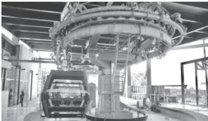
Con una inversión estratégica que supera los 6 mil millones de pesos, el Gobierno de Michoacán consolida una transformación sin precedentes en la infraestructura urbana del estado.
