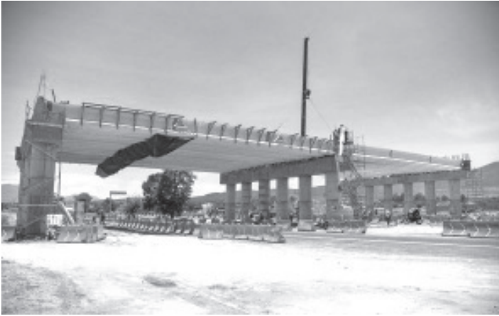
La construcción del primer segmento del segundo anillo periférico de Morelia, beneficiará a más de 16 mil personas que lo transitarán a diario, para trasladarse entre la salida a Pátzcuaro y la salida a Quiroga, obra que reporta actualmente un 15% de avance, informa la Secretaría de Comunicaciones y Obras Públicas (SCOP) de Michoacán.
