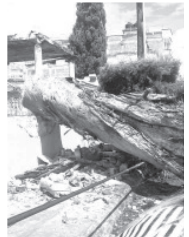
Personal de Parques y Jardines derribó este miércoles un árbol seco que estaba al interior del panteón municipal San Carlos. Durante las maniobras, una parte de la barda del cementerio se destruyó pero no hubo afectaciones a cables, tumbas, ni viviendas cercanas.
