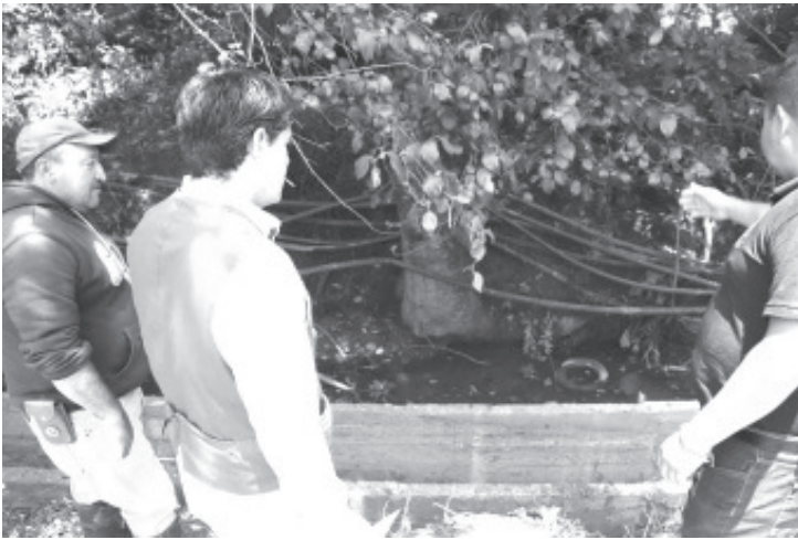
Toño Ixtláhuac supervisó el avance de la construcción de un canal de riego en Curungeo que abastecerá a más de 500 habitantes del centro de la tenencia y localidades cercanas.
