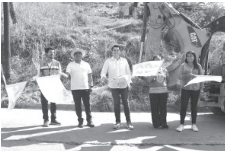
El gobierno de Zitácuaro inició trabajos de construcción de andador en la colonia Educación, esta obra se suma a las ya realizadas por la actual administración.
