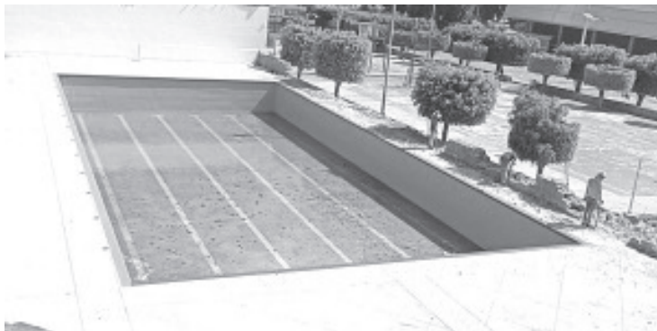
En menos de un mes, estará terminada la alberca semi olímpica que se construye en estos momentos en la Unidad Deportiva Siglo XXI, únicamente le faltan unas gradas así como la instalación del panel solar para mantener en buena temperatura el agua.
