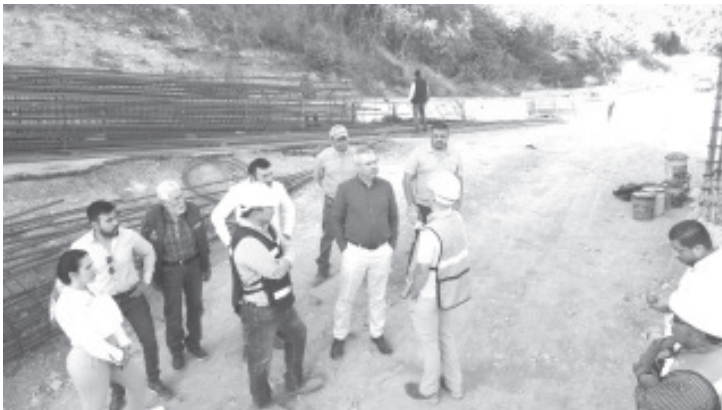
El gobernador Alfredo Ramírez Bedolla recorrió y supervisó los trabajos de rehabilitación del tramo carretero, de la autopista Siglo XXI, afectado por el socavón registrado en 2021.
