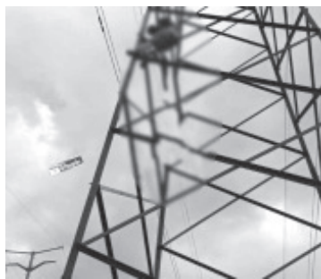
Una persona subió a una torre metálica de la Comisión Federal de Electricidad, y sufrió quemaduras de segundo y tercer grado.
