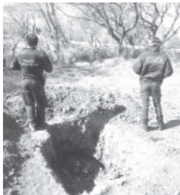
Agentes de la Policía Michoacán ubicaron a un costado de un balneario, un hoyo donde se encontraba un ducto de PEMEX, que contaba con herramienta para sustraer combustible ilícito.
