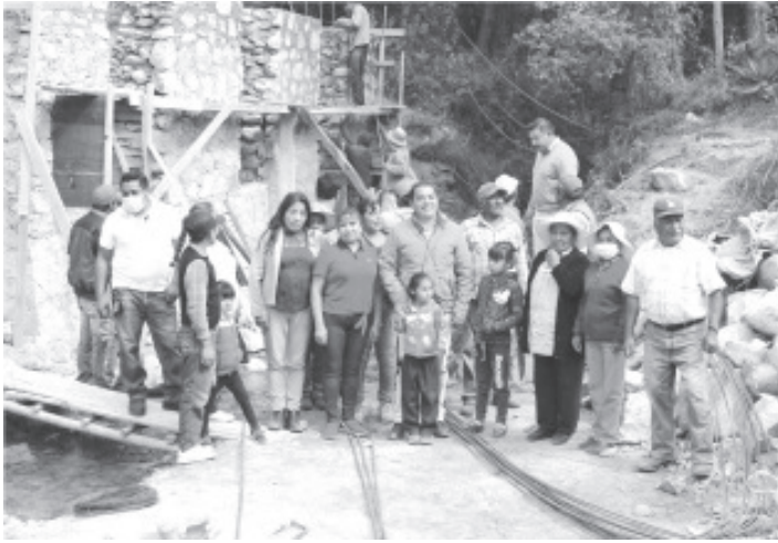
Me da mucho gusto que las obras se estén haciendo con calidad, y que sean las personas de la localidad quienes están trabajando en ellas, algunas ya están comenzando la segunda etapa.
