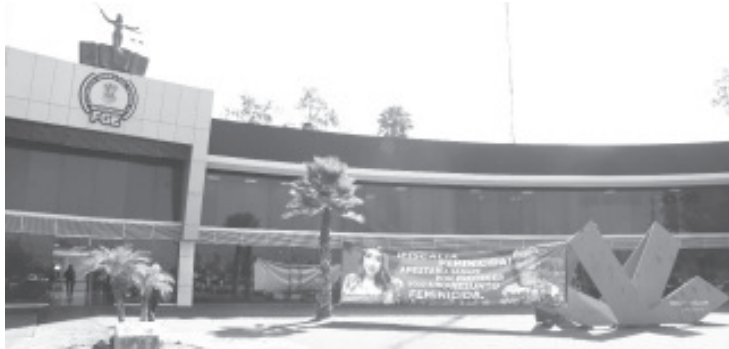
López Solís, ordenó que fueran reinstaladas las lonas de protesta por el feminicidio de Jessica G., que indebidamente fueron retiradas por personal de Servicios Generales.
