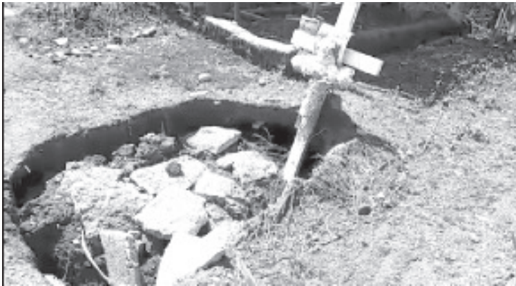
Los hundimientos se encuentran en todo el panteón, pero principalmente en la mitad, aproximadamente en la fila 18 del lado derecho.
