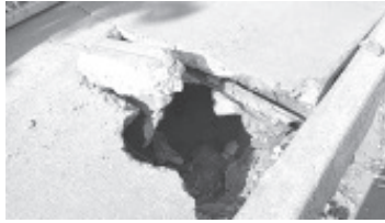
Hay un poste caído, uno más se encuentra a punto de venirse abajo con todo y banqueta, otro de alumbrado público doblado y desde hace mucho tiempo no funciona.
