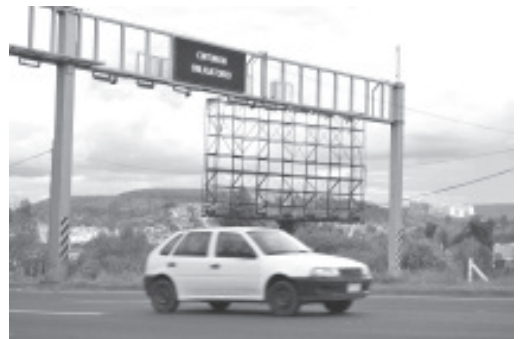
Operadores del C5i mantienen labores las 24 horas del día, donde a través de los arcos carreteros, los cuales se encuentran en las principales ciudades y puntos estratégicos de mayor afluencia vehicular.
