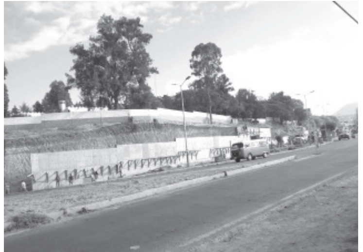
Los comerciantes intentan salir solos adelante, sin ayuda de nadie, y todos los días tratan de abrir y seguir resistiendo, ya que la terminación de la obra va para largo.
