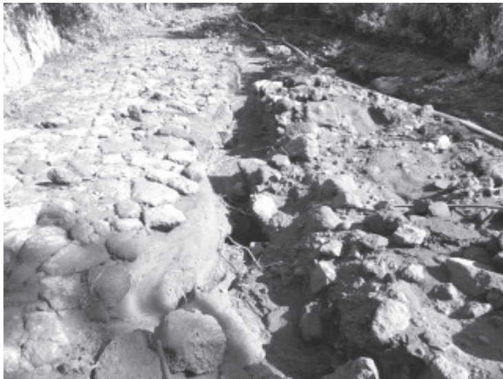
Mediante un recorrido por el lugar pudimos captar zanjones a los costados y a mitad del camino, de metro y medio de profundidad.
