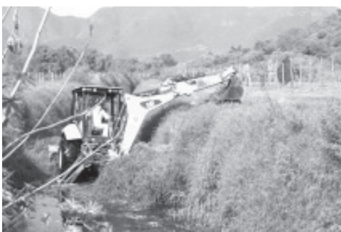
El trabajo que se realizó fue en un tramo de aproximadamente 500 metros, en los que se retiró basura, piedras y se realizará la poda de la vegetación que se encuentra en los márgenes del canal.
