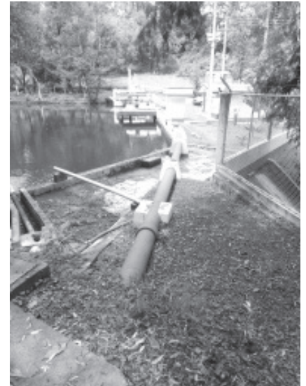
Germán Tena Fernández, adelantó que para este 2020 se tienen contemplados proyectos como la modernización de la Planta de Tratamiento de Aguas Residuales de Zitácuaro.
